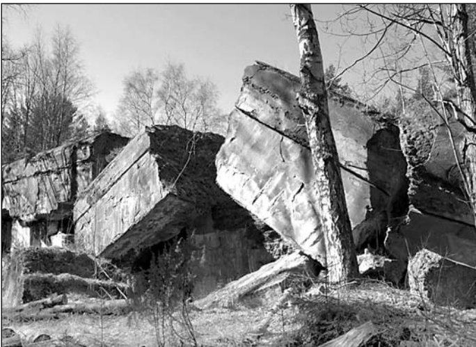
Руины первого блока. 2008 г. Фото предоставил Хейки Муда (Эстония)
