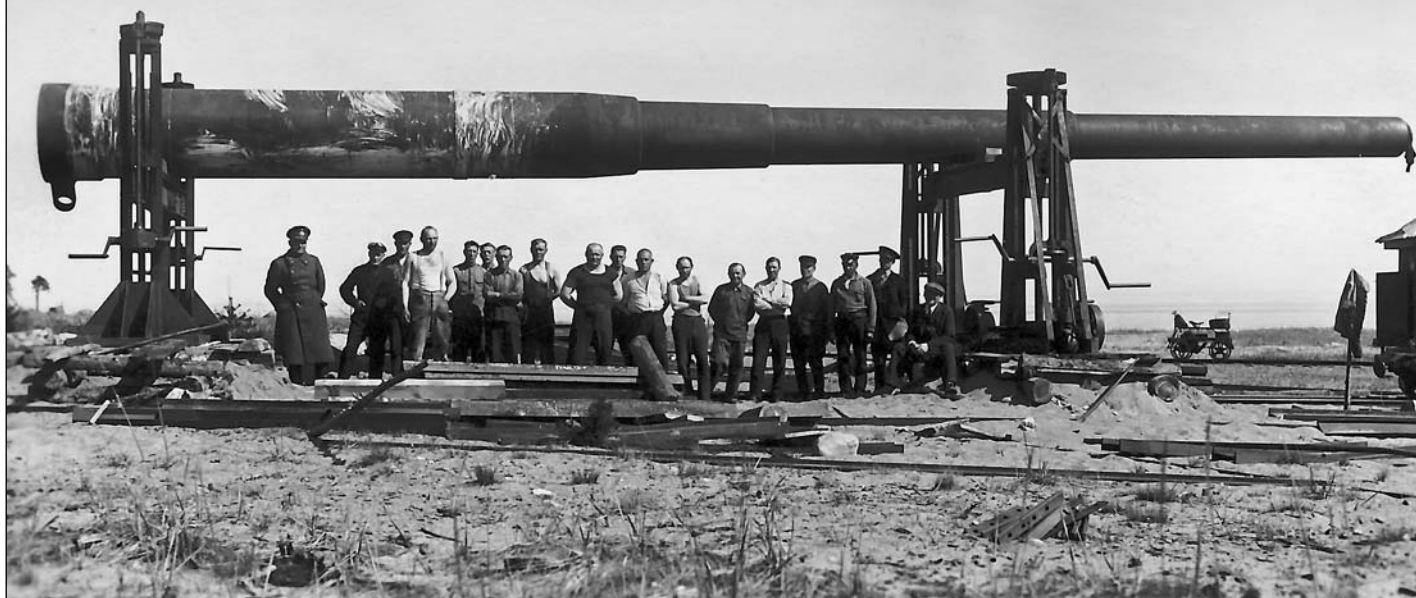
Ствол 12-дм орудия поднят на домкраты для укладки на платформу. 1934 г. Фото предоставил Индрек Лиива (Эстония)
