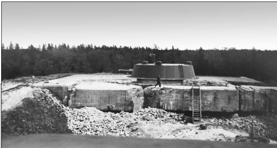
Первая (правая) башня эстонской батареи №1 (бывшая русская батарея №15), разрушения после взрыва 27.02.1918 г. Левая стена блока (на переднем плане) взрывом зарядного погреба расколота на куски, перекрытие разрушено. Башня закинута. 1919 г. Фото предоставил Роберт Нерман (Эстония)
