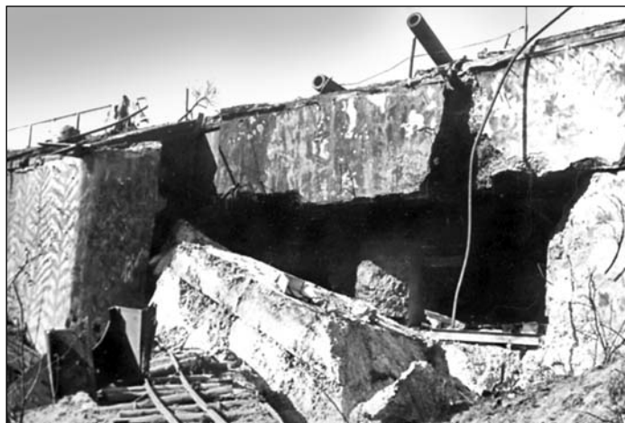
Взорванный первый блок батареи. 13.10.1941 г.
