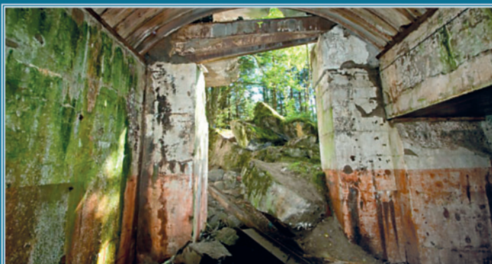
Блок укрытия для прожектора
