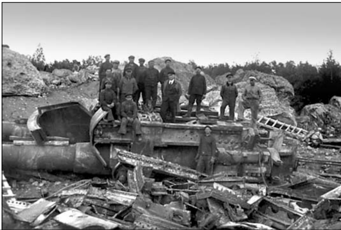
Разборка завершается (башня в перевернутом виде). Хорошо видны орудия и их станки. 1933-34 гг. http://fortoved.ru
