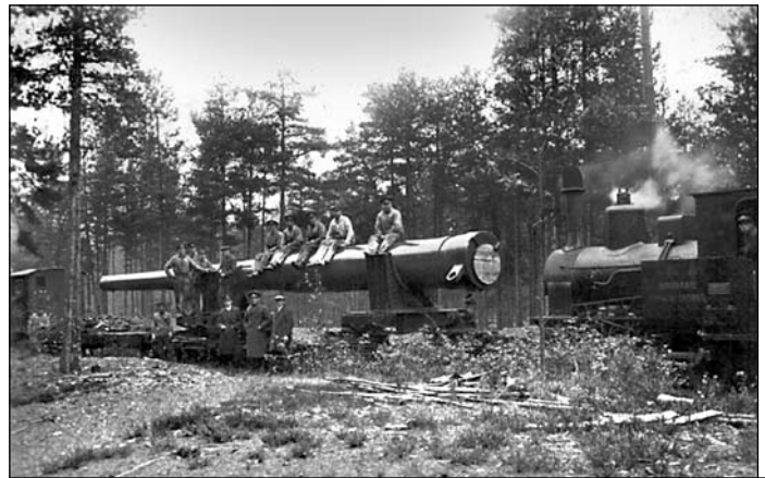
Транспортировка 12-дм ствола по крепостной железной дороге с батареи на склад. Нарген, 1934 г.
