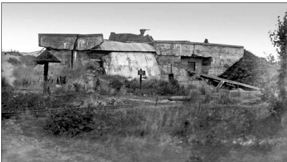
Правая башня. На переднем плане вырванная взрывом стенка зарядного погреба и временная деревянная заделка. 1924-26 гг. Фото предоставил Индрек Лиива (Эстония)
