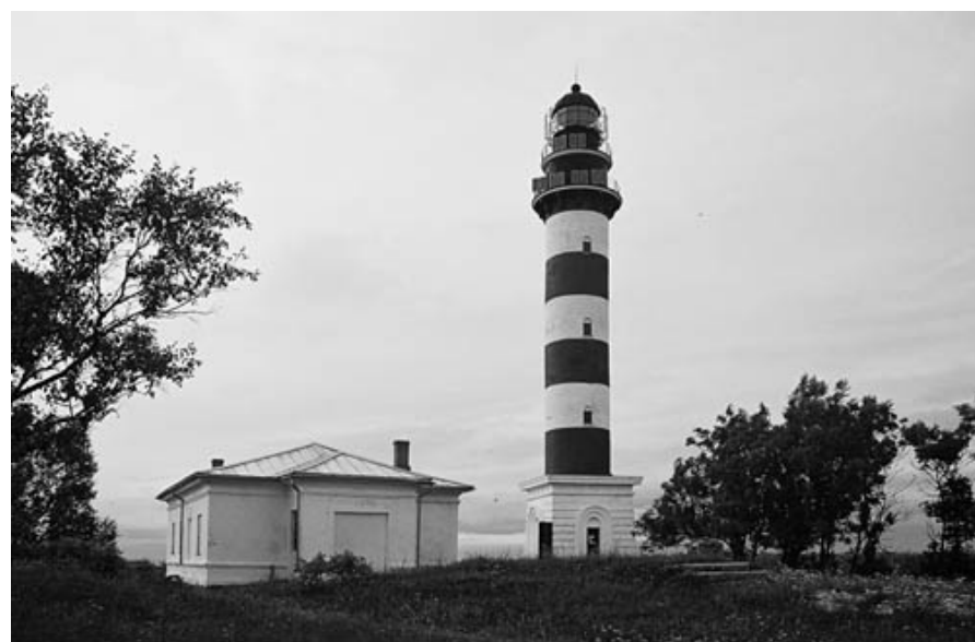
Илл. 3. Маяк 1954 г., основание маяка 1850 г. и здание моторной электростанции 1910 г.
