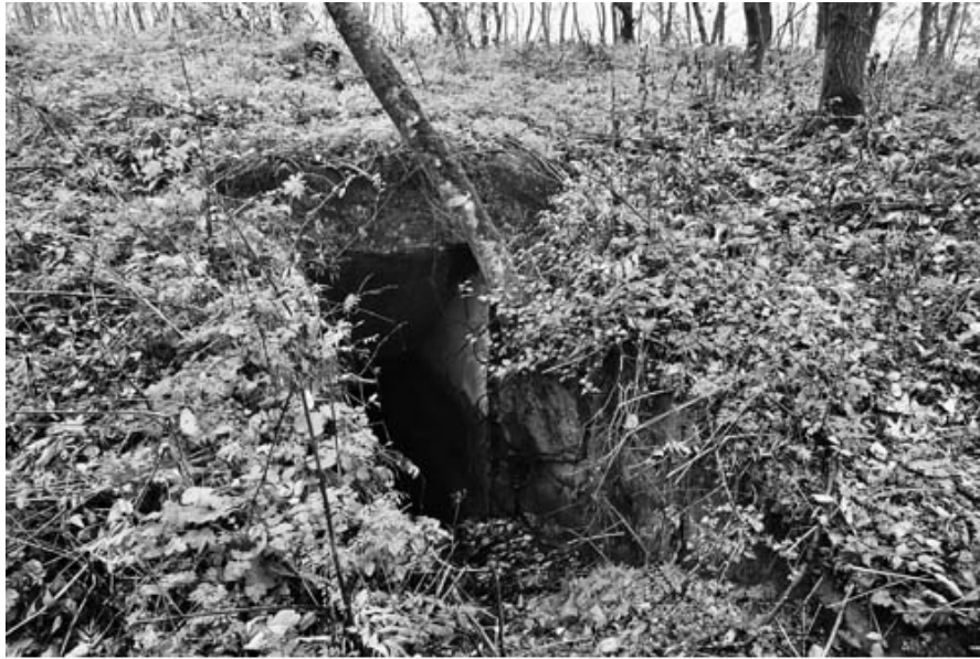
Илл. 11. Главный вход в подземный блок командного пункта
